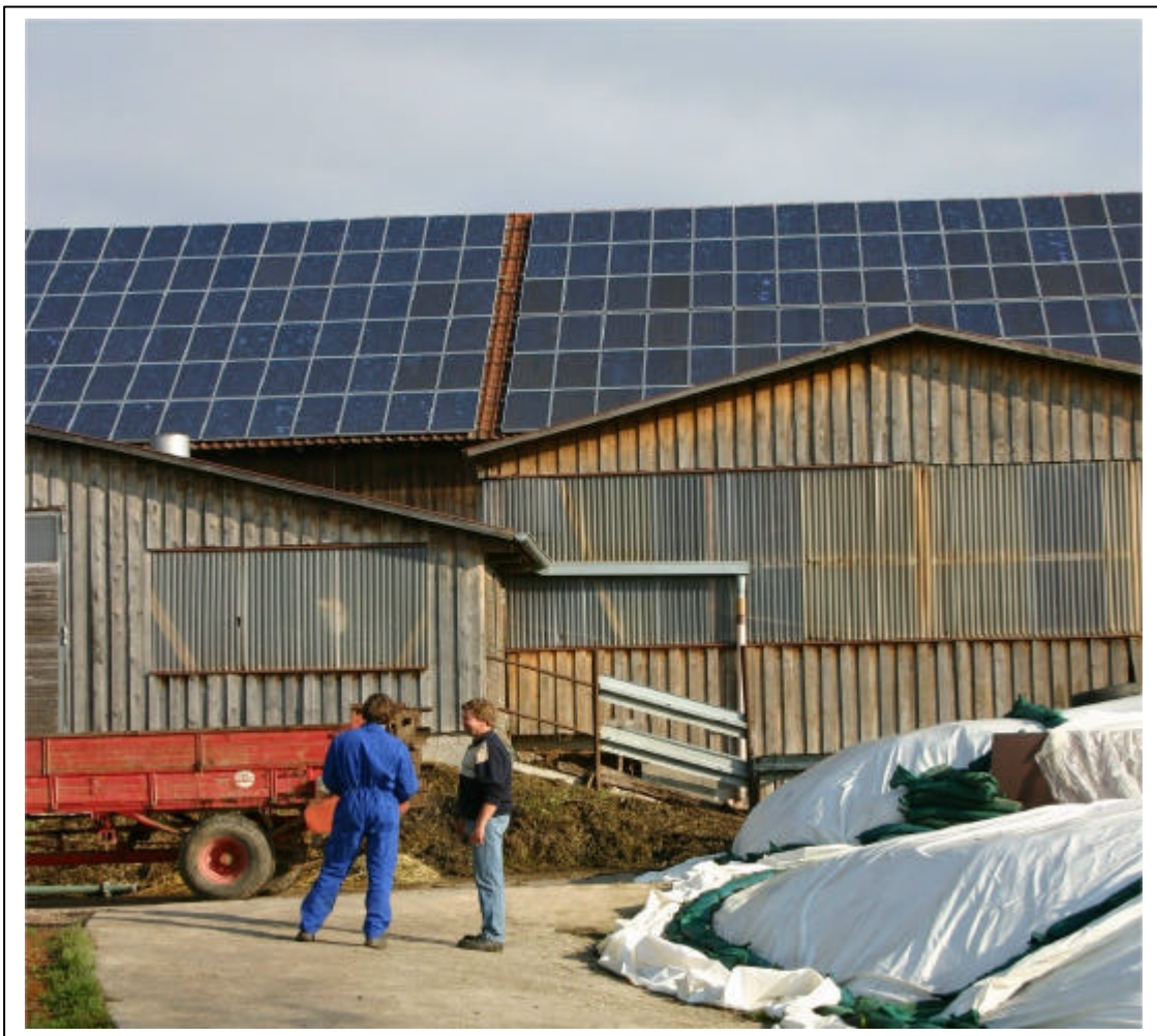
Photovoltaikanlage auf dem Demeter-Betrieb Blanc in Wolpertshausen
